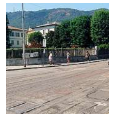
Lavori entro il 15 agosto
